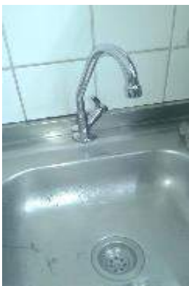
Figuras 01: Manutenção e instalação na torneira da sala de recolhimento de materiais contaminados;
