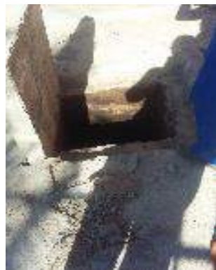
Figuras 04 e 05: Abertura de caixa de esgoto para limpeza e inspeção;
