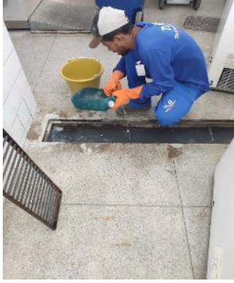
Figura 07: Desobstrução e limpeza da via d'agua na sala destinada ao recolhimento e descarte de residuos contaminados;
