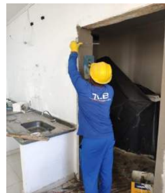
Figuras 06 e 07: Requadramento de vão para instalação de porta;
