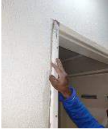
Figura 08: Fixação do alisar na sala do Almojarifado;
