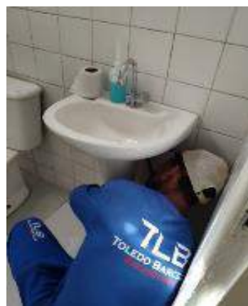
Figura 07: Ajuste em engate com vazamento.
