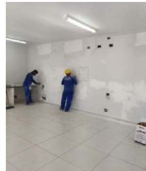
Figuras 02 e 03: Emassamento de paredes na recepção de doadores e sala de coleta;
