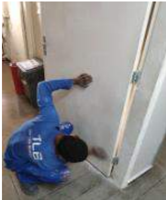
Figura 01: Lixamento de massa pva em porta da copa;
