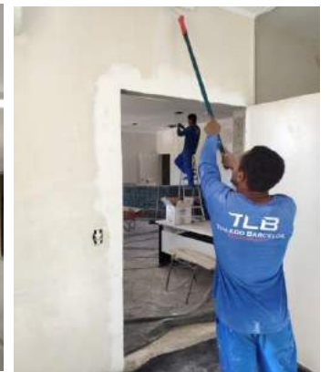
Figuras 10 e 11: Aplicação da primeira demão de tinta na sala de coleta.
