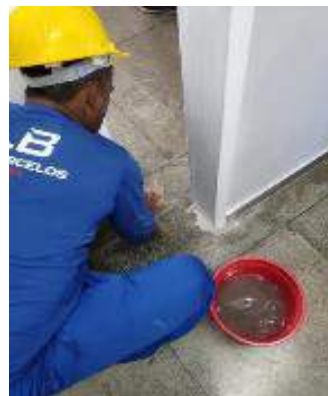
Figura 02: Limpeza do pós obra no piso proximo aos portais instalados na reforma;
