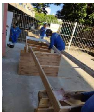
Figuras 01 e 02: Emassamento de portas e portais;
