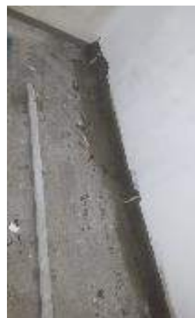
Figuras 05 e 06: Execução de rodapé em cimento queimado.
