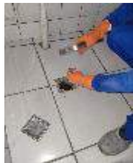
Figuras 03 e 04: Substituição de ralos com defeitos;
