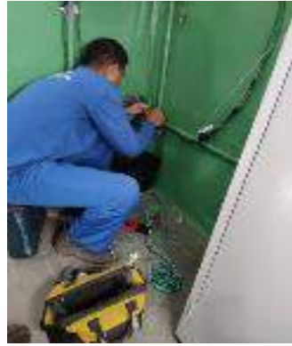
Figuras 05 e 06: Instalação de ponto lógico no Centro POP;
