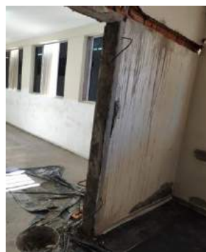
Figuras 02 e 03: Emassamento de paredes na recepção de doadores e sala de coleta;
