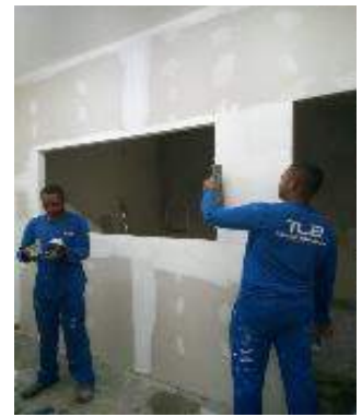
Figuras 03 e 04: Emassamento e requadro da parede interna da sala reformada;
