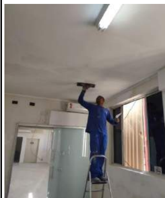
Figuras 06 e 07: Emassamento de teto e paredes para correção;
