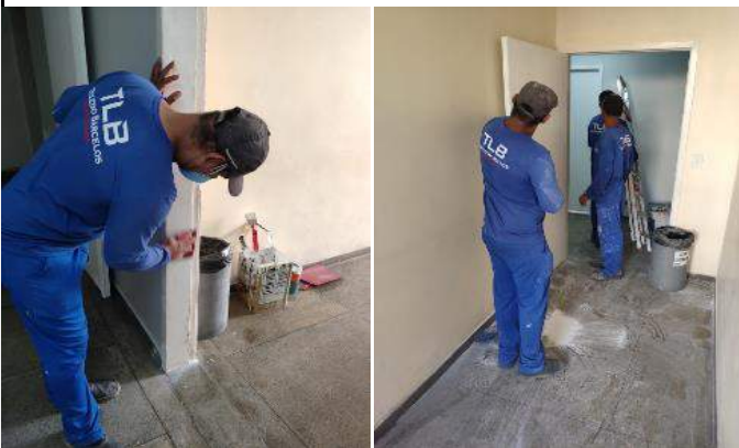
Figuras 03 e 04: Lixamento da porta e do portal localizado no corredor de passagem de resíduos contaminados;
