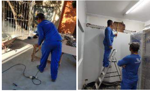
Figuras 07 e 08: Medição e dimensionamento de gesso acartonado para fechamento de cortes na parede da sala de TI;
