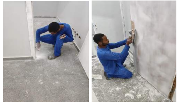
Figuras 02 e 03: Emassamento da porta e portal da sala do TI;
