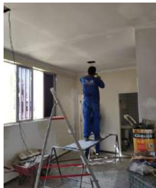
Figuras 04 e 05: Marcação do local de instalação das luminárias;
