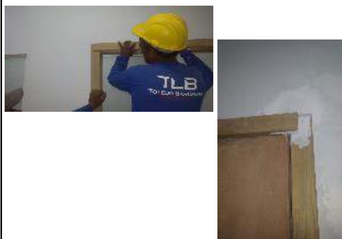
Figuras 06 e 07: Instalação de alisar na sala do TI;
