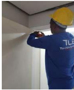
Figura 04: Reparo na dobradiça da porta localizada no corredor principal do primeiro pavimento;
