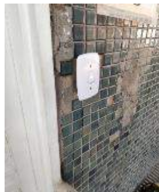
Figura 02: Instalação de campainha na sala de transfusão;
