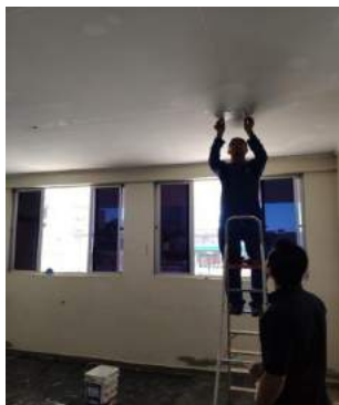
Figuras 04 e 05: Marcação do local de instalação das luminárias;
