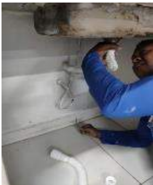
Figuras 01 e 02: Troca do sifão da sala de coleta após identificação de vazamento no mesmo;
