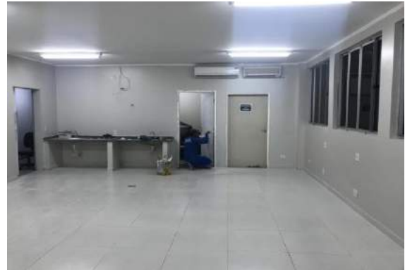
Figura 02: Finalização da pintura da sala de coleta;
