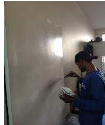
Figura 06 : Aplicação de massa pva na porta da sala destinada a coleta externa;
