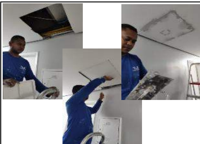
Figuras 03, 04 e 05: Fechamento de abertura em gesso no corredor térreo;
