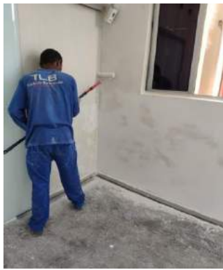
Figuras 08 e 09: Aplicação da primeira demão de tinta na sala de espera de doadores;
