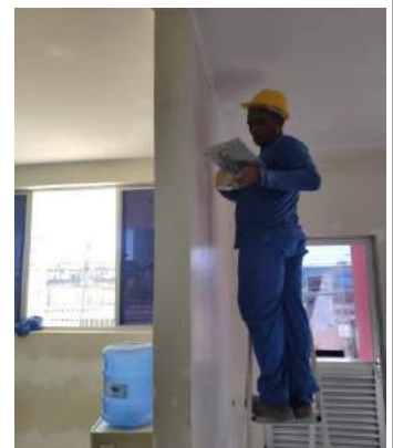
Figuras 06 e 07: Emassamento de teto e paredes para correção;
