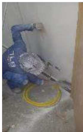
Figuras 03 e 04: Lixamento de massa pva nas paredes da sala do TI;
