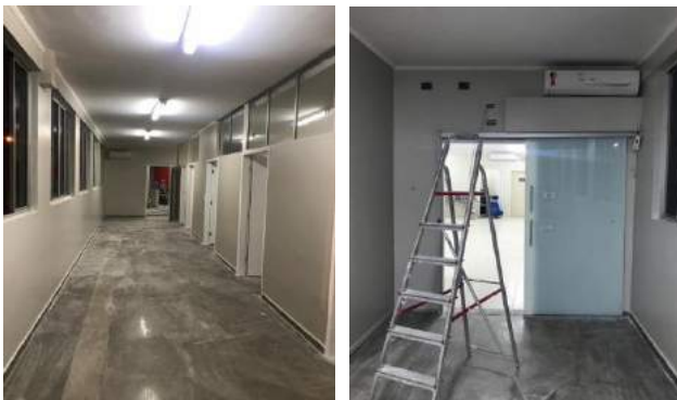
Figuras 03 e 04: Finalização da reforma e pintura da sala de espera de doadores;
