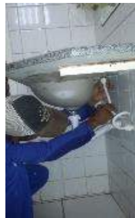
Figura 05: Troca de engate no lavatório da pia do sanitário de doadores;
