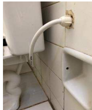
Figuras 08, 09: Caixa acoplada no vaso sanitário estava com vazamento, foi feito a instalação de um engate novo e o problema foi solucionado;
