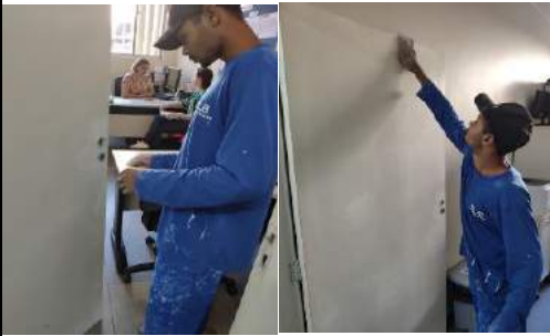
Figuras 05 e 06: Lixamento de porta e portal na sala responsável pela coleta externa da unidade.
