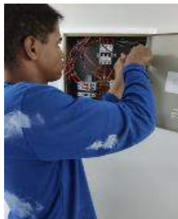
Figura 04: Instalação de circuito de ar condicionado;
