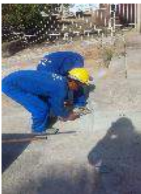
Figuras 04 e 05: Abertura de caixa de esgoto para limpeza e inspeção;
