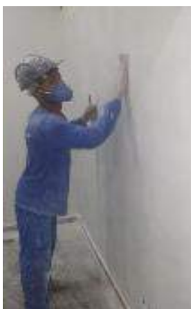
Figuras 03 e 04: Lixamento de massa pva nas paredes da sala do TI;
