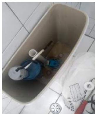
Figuras 08 e 09: Troca de kit de caixa acoplada no sanitário masculino da farmácia;
