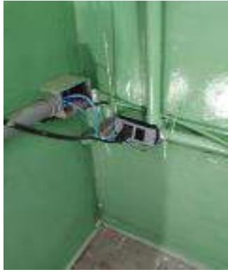
Figuras 05 e 06: Instalação de ponto lógico no Centro POP;
