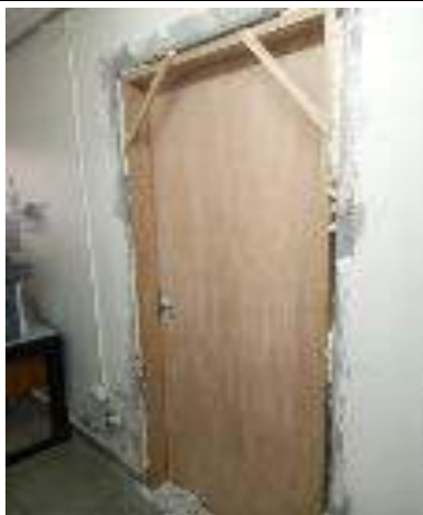
Figura 05: Instalação de porta na sala do TI, em espuma expansiva;
