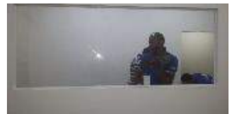
Figuras 06 e 07: Instalação de vidro fixo em vidro temperado na sala do TI;
