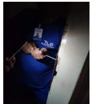
Figuras 04 e 05: Remoção da fechadura da sala do almoxarifado para ajuste;
