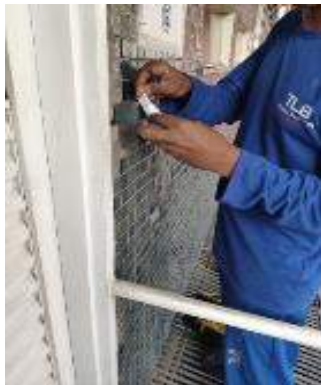
Figura 01: Remoção de campainha danificada na transfusão;
