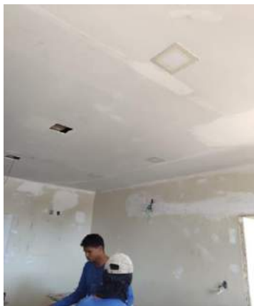
Figura 05: Instalação de luminárias em LED de embutir;
