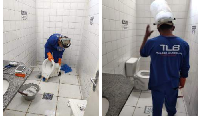
Figura 08 e 09: Desentupimento do vaso sanitario do banheiro masculino localizado no segundo pavimento.
