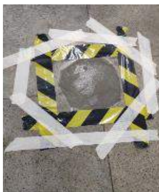
Figuras 05 e 06: Reparo no piso do primeiro pavimento da unidade após mau isolamento de tubulação;
