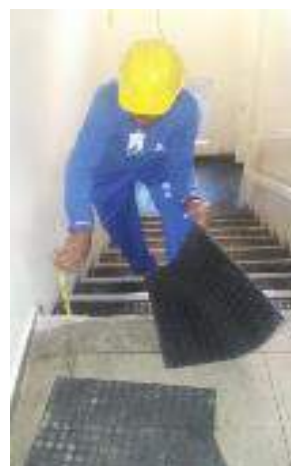
Figuras 08: Instalação de piso moeda na escada que dá acesso ao almoxarifado.
