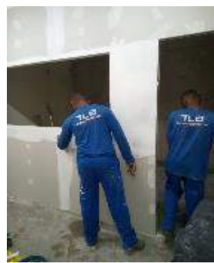
Figuras 03 e 04: Emassamento e requadro da parede interna da sala reformada;
