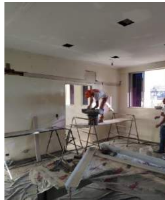
Figuras 03 e 04: Fabricação de caixote e fechamento de rasgo em gesso acartonado para rede frigorígena;
