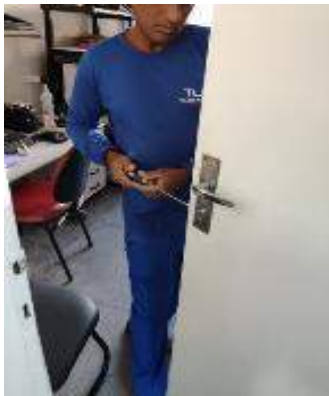
Figura 01: Reparo na fechadura da porta na sala do SESMT;
