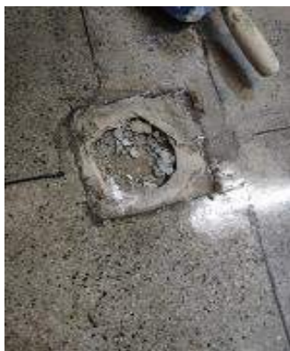
Figuras 05 e 06: Reparo no piso do primeiro pavimento da unidade após mau isolamento de tubulação;
