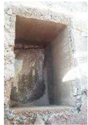
Figuras 02 e 03: Foi feito a abertura de caixas de esgoto para inspeção e reforma;
