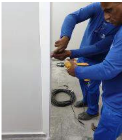
Figura 03: Ajustes na fechadura da sala de TI;
