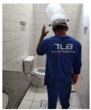
Figura 10: Desobstrução da via d'agua no vaso sanitario do banheiro masculino no segundo pavimento da unidade.
