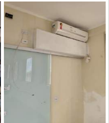
Figuras 03 e 04: Fabricação de caixote e fechamento de rasgo em gesso acartonado para rede frigorígena;
