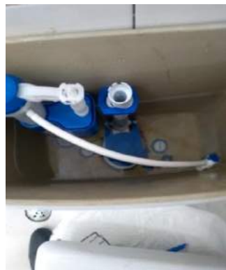
Figuras 08 e 09: Troca de kit de caixa acoplada no sanitário masculino da farmácia;
