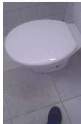
Figuras 02: Troca de assento de vaso no sanitário feminino;
