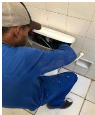
Figuras 08, 09: Caixa acoplada no vaso sanitário estava com vazamento, foi feito a instalação de um engate novo e o problema foi solucionado;
