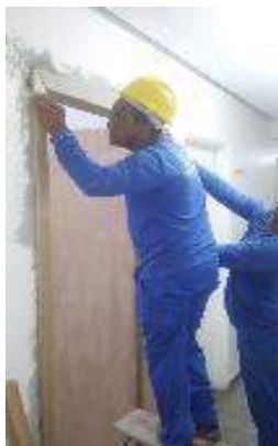
Figura01: Instalação de porta na sala do TI;
