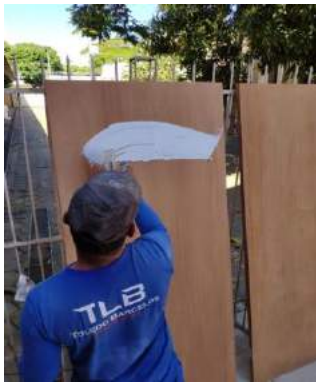
Figuras 01 e 02: Emassamento de portas e portais;
