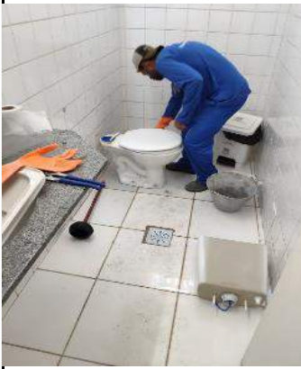
Figura : Desentupimento do vaso sanitario no banheiro masculino;
