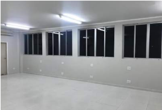
Figura 01: Finalização da reforma da sala de coleta;
