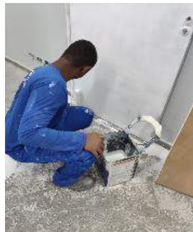
Figura 05: Aplicação do fundo preparador na sala do TI.
