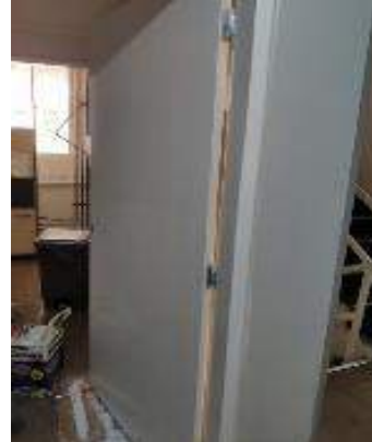
Figura 02: Aplicação de tinta esmalte na porta da copa;
