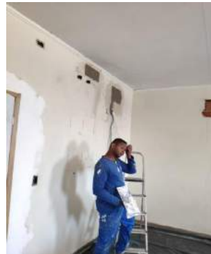
Figuras 02 e 03: Emassamento de paredes na recepção de doadores e sala de coleta;
