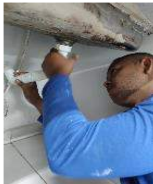
Figuras 01 e 02: Troca do sifão da sala de coleta após identificação de vazamento no mesmo;
