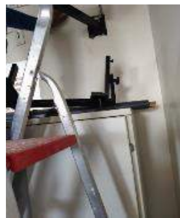
Figura 04: Instalação de novo suporte para televisão na recepção de doadores;
