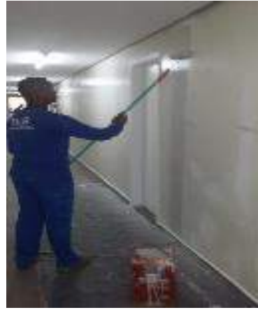
Figura 07: Manutenção em pintura do corredor térreo.
