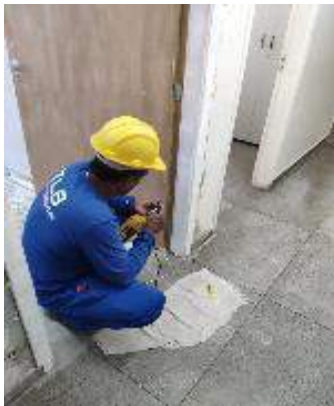
Figura 01: Ajustes e regulagem na porta instalada na sala do TI;
