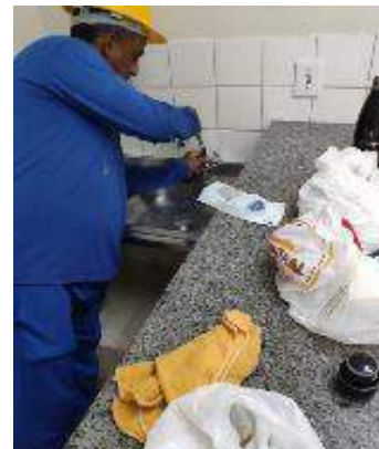
Figura 04: Reparo na torneira da copa no primeiro piso após verificação de vazamento de água na mesma;
