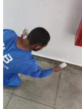
Figura 02: Acabamento em pintura no rodapé da sala do corredor Térreo;
